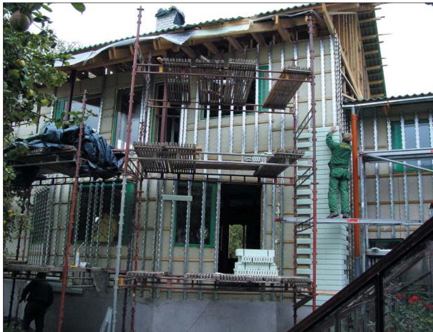
Aluskarkassi paigaldus ja nurga ladumine
