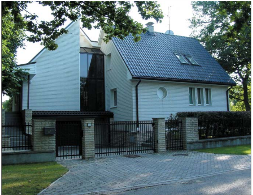
MARMOROC-fassaadikattetehnoloogiaga renoveeritud elamu
